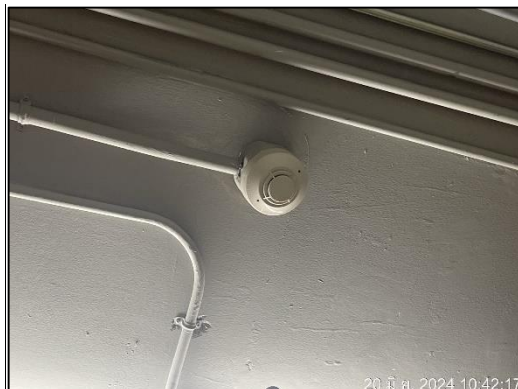
ภาพที่ 37 เครื่องตรวจจับควัน และเครื่องตรวจจับความร้อน
