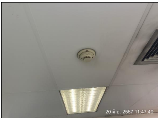
ภาพที่ 37 เครื่องตรวจจับควัน และเครื่องตรวจจับความร้อน
