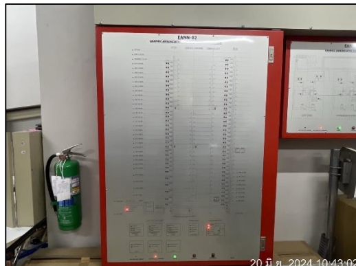
ภาพที่ 36 แผงควบคุม (Fire Alarm Control Panel: FCP)
