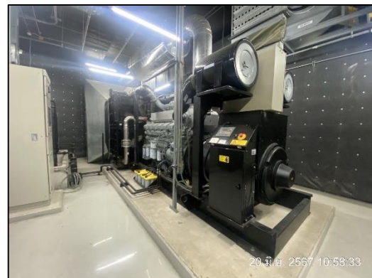
ภาพที่ 22 เครื่องกำเนิดไฟฟ้าสำรอง (Generator)
